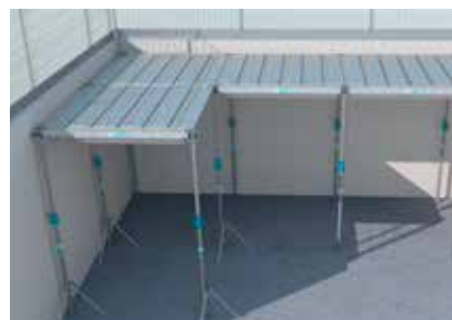
Les poutrelles extensibles permettent de se rapprocher des bords de la cellule
