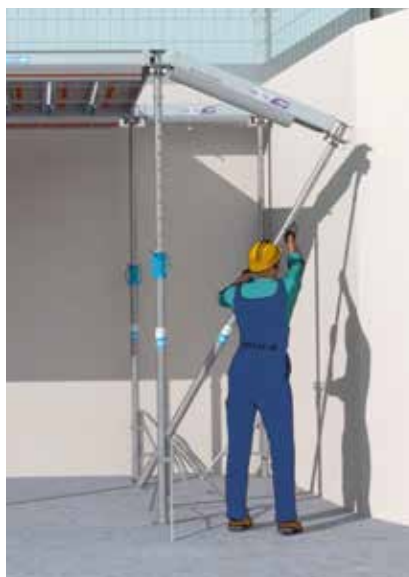
Les poutrelles extensibles permettent de se rapprocher des bords de la cellule
